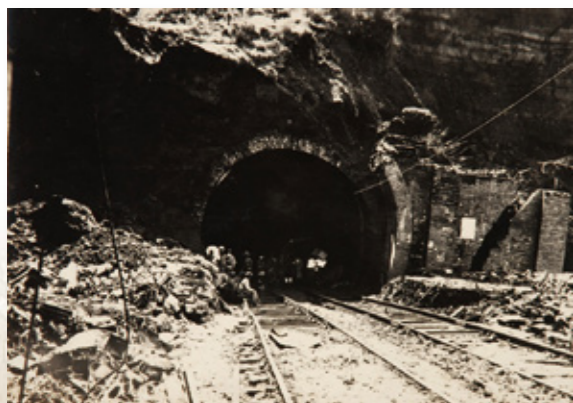
④ 元町トンネルの被害 1923(大正12)年 当館所蔵
