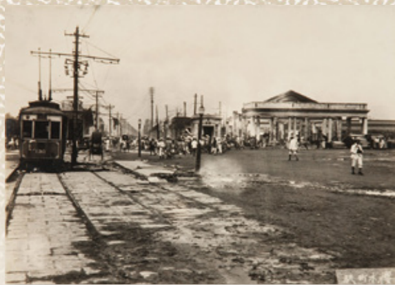
② 桜木町停留所に停車した市電130号車 1923(大正12)年 横浜開港資料館所蔵
