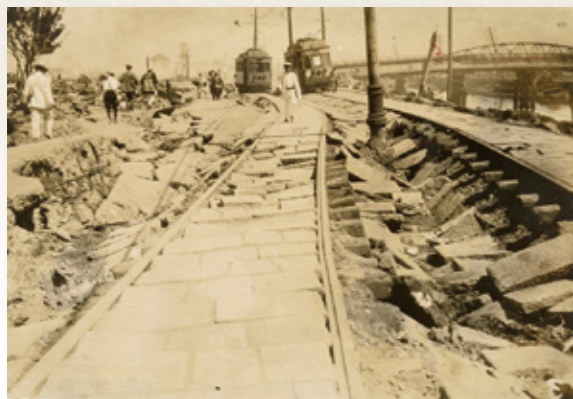
③ 新吉田川周辺の被災状況 1923(大正12)年 横浜開港資料館所蔵
