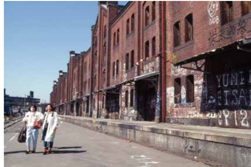
① 赤レンガ倉庫 平成元(1989)年3月19日
