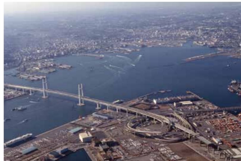
③ 横浜ベイブリッジ 平成元(1989)年12月20日
