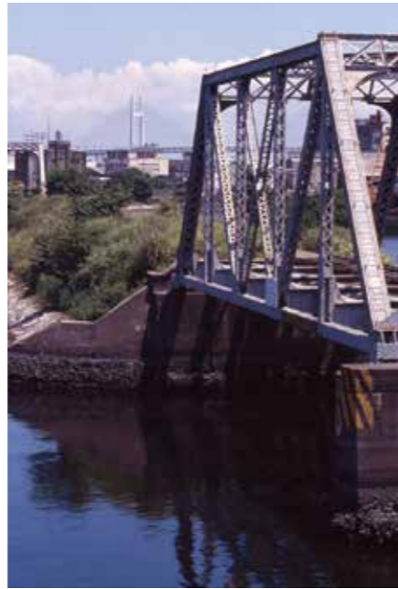
④ 港一号橋梁 平成6(1994)年7月24日
