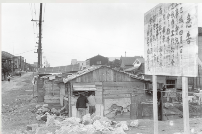
④ 桜川地区のバラック 1955(昭和30)年10月 1948(昭和23)年から埋め立てが始まった桜川では、不法占拠のバラックが後を絶たず、横浜市によって強制撤去された。
