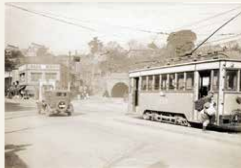
③麦田方面から見た市電のトンネル
