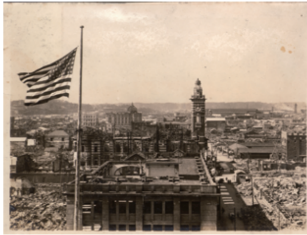
②横浜中央電話局屋上からみた被災状況 大正12(1923)年10月上旬撮影 長島弘氏寄贈・横浜開港資料館所蔵
