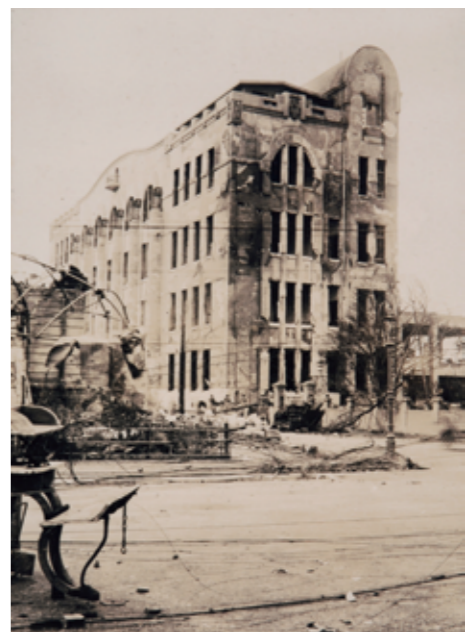
③被災した横浜中央電話局 大正12(1923)年9月 前川謙三撮影・横浜開港資料館所蔵
